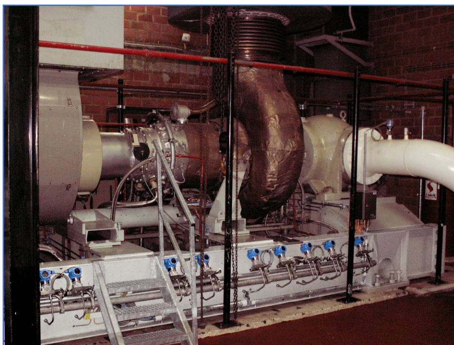
Газовая турбина Solar Centaur с компрессором природного газа
